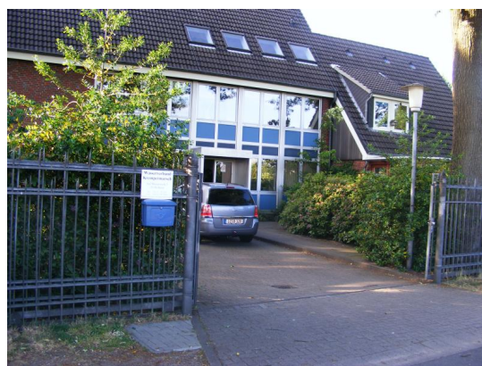
Das Verbandsgebäude des Wasserverbandes
